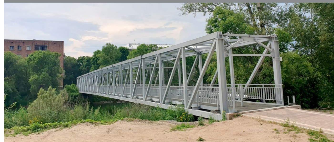
МЕТАЛЛИЧЕСКАЯ КОНСТРУКЦИЯ ПЕШЕХОДНОГО ПЕРЕХОДА ЧЕРЕЗ ДРЕНАЖНЫЙ КАНАЛ В Г. АБАКАНЕ
