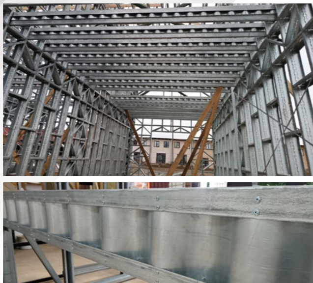
МЕТАЛЛОКОНСТРУКЦИИ «L-TECHNOLOGY» ТИПА «ГОФРОБАЛКА ЛСТК» ДЛЯ КОЛОНН И ПЕРЕКРЫТИЙ
